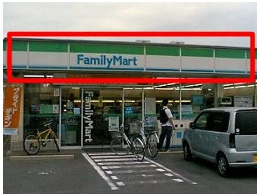
図 1 店舗上部に存在する帯状看板
